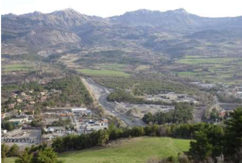
Figure 4 : Système d'endiguement du torrent du Dêvezet
