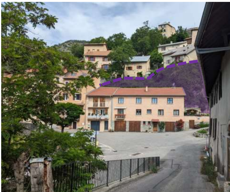
Figure : Zone de chute de blocs (en violet)
