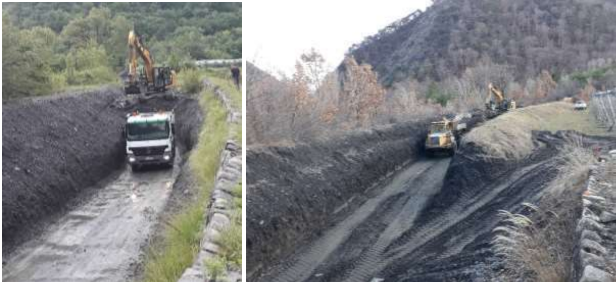
Figure : Exemple de curage et de remodelage au ravin des Gorges – Commune de Rochebrune
