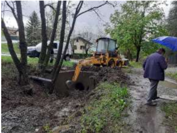
Figure : à gauche : secteur amont, embâcle à l'entrée du passage busé – à droite : décanteur eaux du torrent et eaux pluviale avant le passage dans le canal d'aspersion à l'aval.
