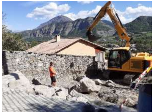
Figure : à gauche : écoulement de matériaux lors des orages de 2023 – à droite, réalisation d'un passage à gué pavé et d'une bèche de dissipation lors des travaux des réseaux du vieux village, à l'amont.
