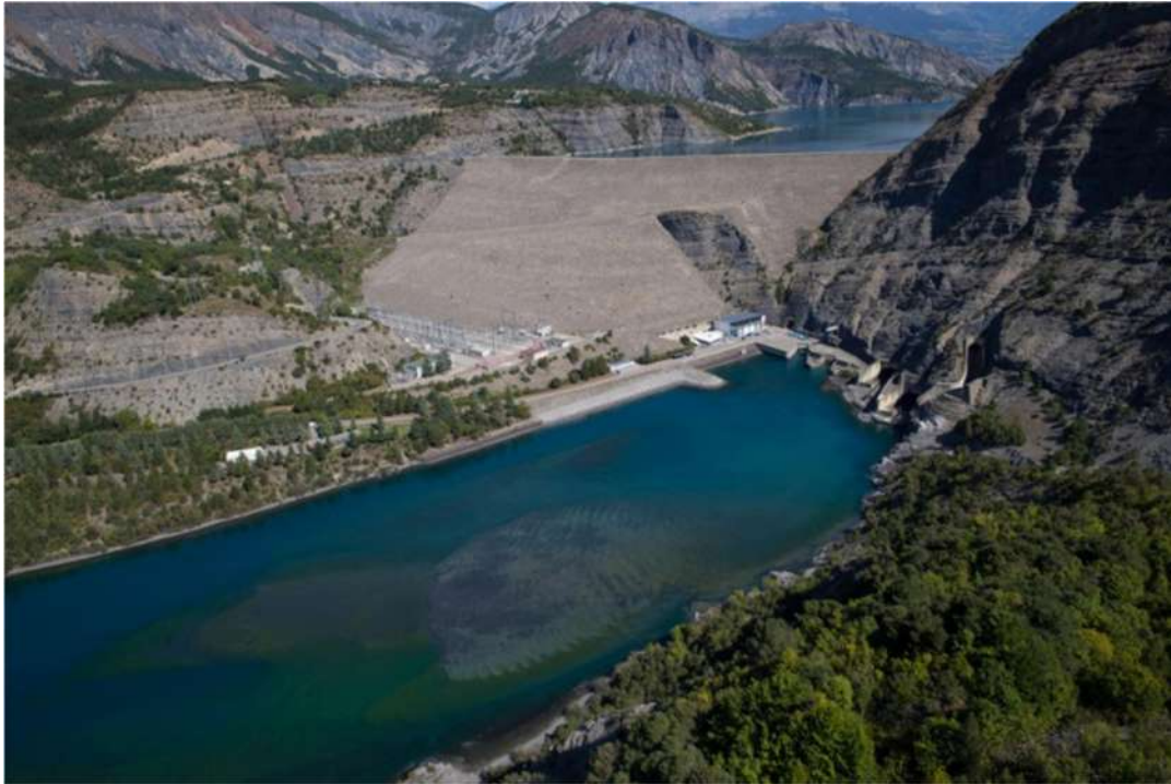
Figure 18: Vue sur le barrage de Serre-Ponçon et son bassin de compensation, implantés sur la commune de Rousset
