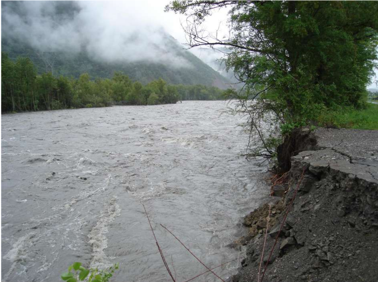
Figure 25 : Erosion linéaire des berges de la Durance – Crue 2008
