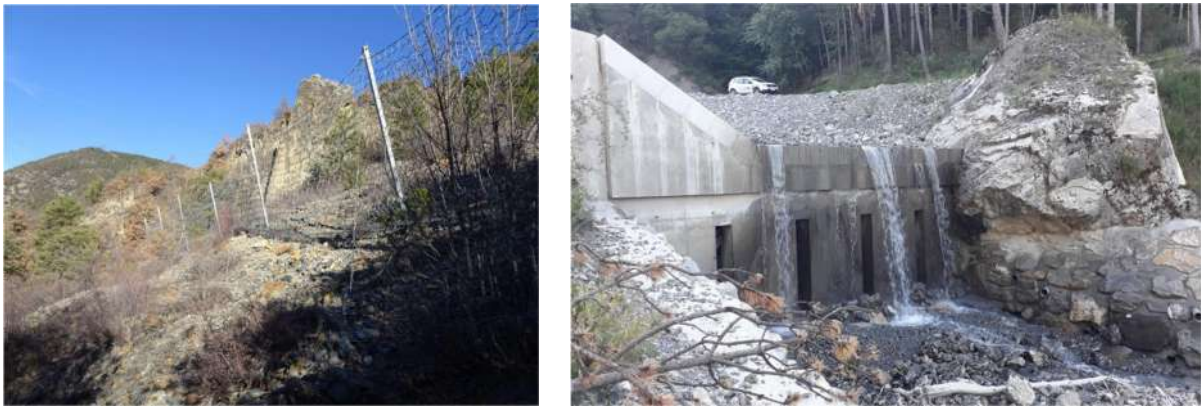
Figure 40 : Filets pare bloc à Rousset et barrage sur le torrent du Dévezet
